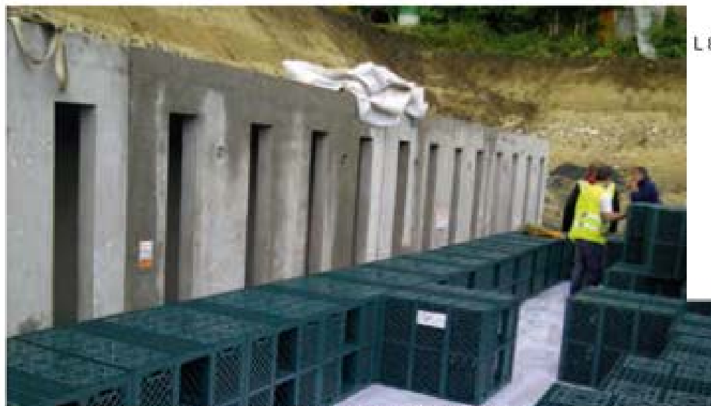
Installation Rigofill et galerie d'inspection béton à Cusset
