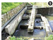
Passé à poissons de Valbonne sans les grilles de protection.
