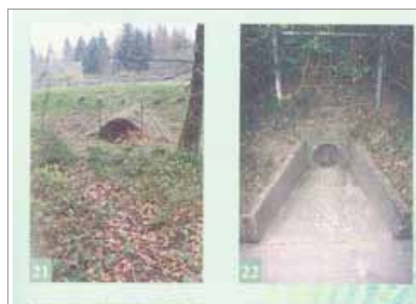
Exemples de passages à faune de type I pour la petite et moyenne faune (Source : Guide technique : Aménagements et mesures pour la petite faune, SETRA)
